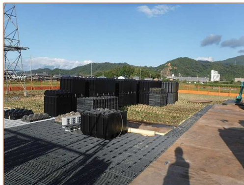
滋賀県電線張管工事
