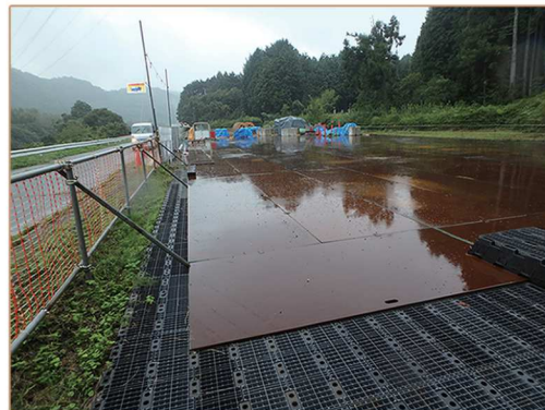
山口市電線張管工事
