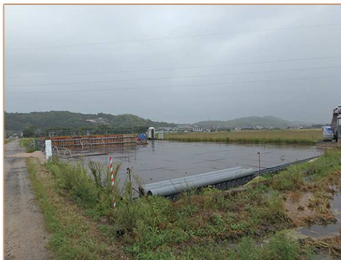
山陽小野田市鉄塔立管工事
