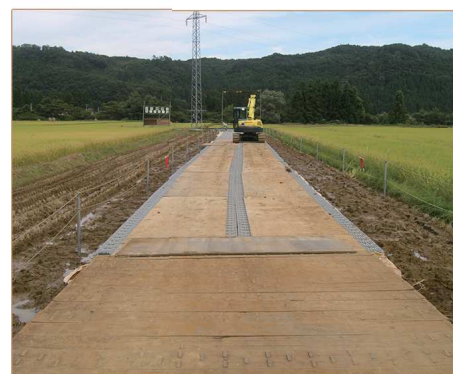
③上面に鉄板を敷設
