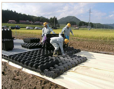
①プラロードを敷設
