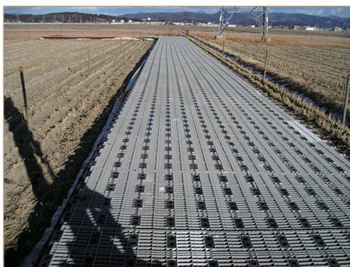
②スペーサーを敷設
