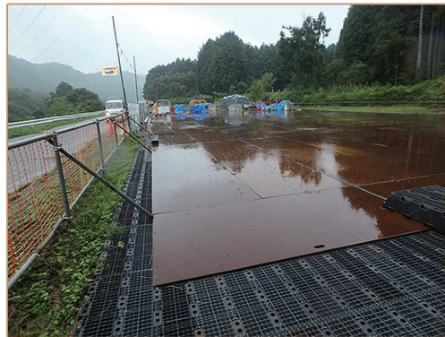
山口市電線張替工事
