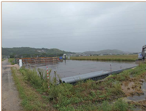
山陽小野田市鉄塔立替工事
