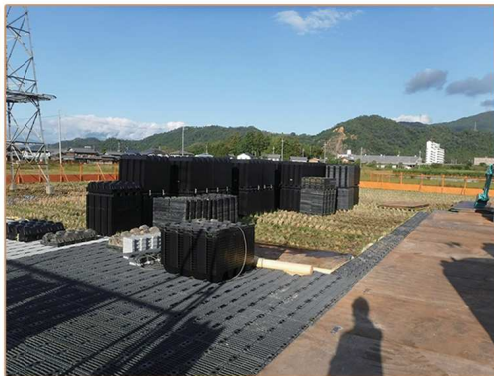
滋賀県電線張替工事
