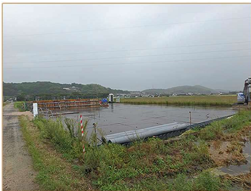
平成30年 山陽小野田市鉄塔立替工事
