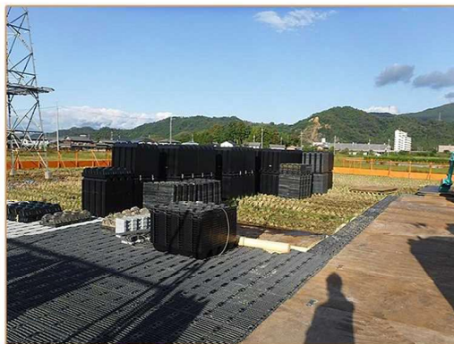
平成30年 滋賀県電線張替工事
