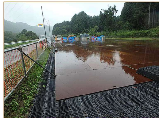
平成30年 山口市電線張替工事
